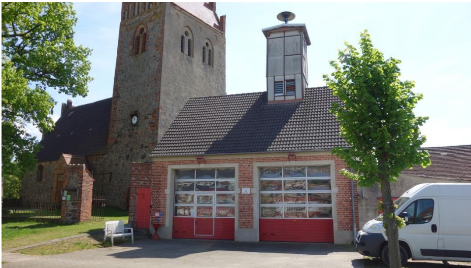
Feuerwehrgerätehaus mit Schulungsraum
