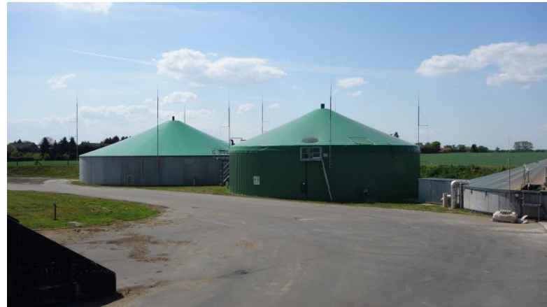
Fermenter und Gärrestlager mit Gasspeicher
