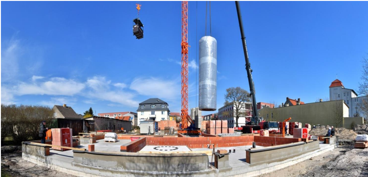
Abbildung 1 Hier findet der erste von zwei Wärmespeichern seinen Platz. Bei dem Vorhaben der WOBA handelt es sich um die ersten energieautarken Mehrfamilienhäuser im Landkreis Oberhavel. Foto: Enrico Kugler/ Wohnungsbaugesellschaft mbH Oranienburg
